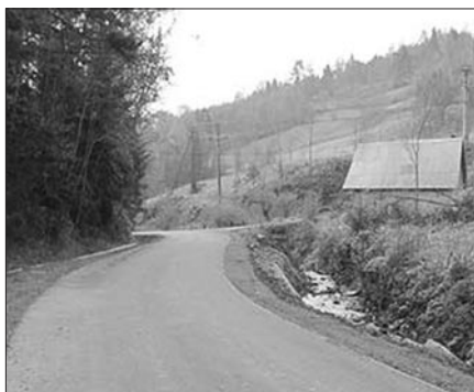
Droga „Łopuszne” w Kasince Matej
