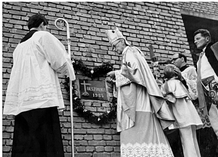
Wmurowanie kamienia węgielnego w nowym kościele
